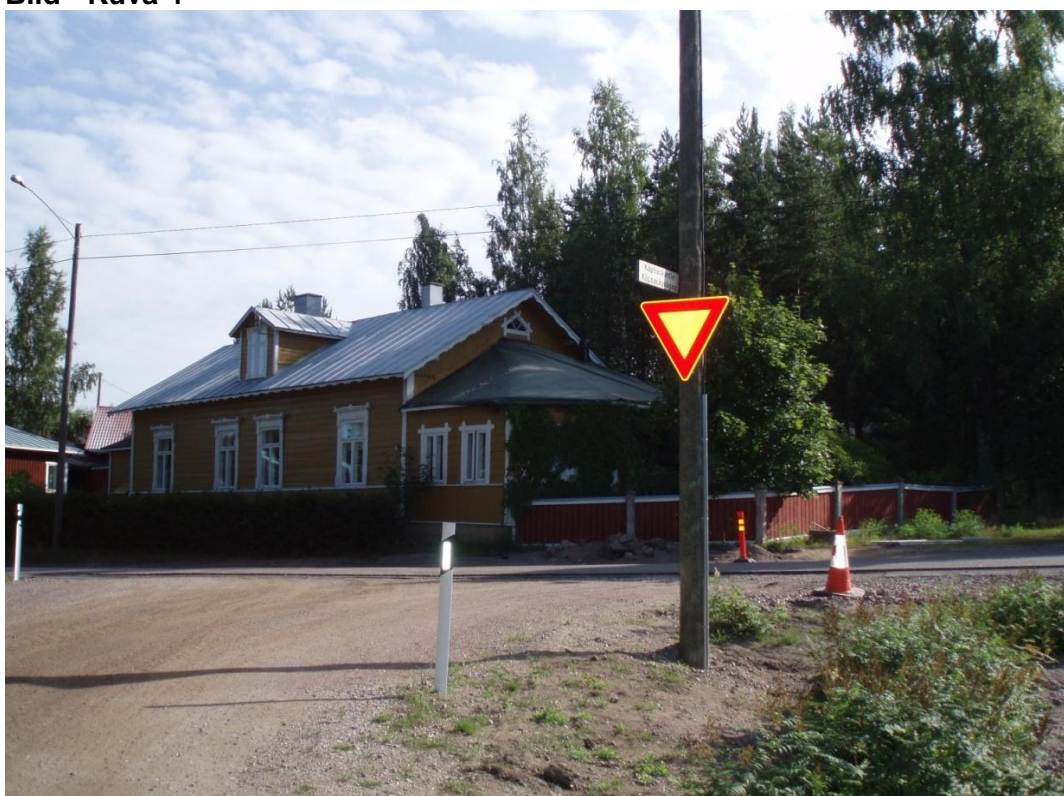
Den nya korsningen från Köpbackavägen till Gamla Valkomvägen 2009 Uusi risteys Köpbackantieltä Vanhalle Valkontielle 2009n
